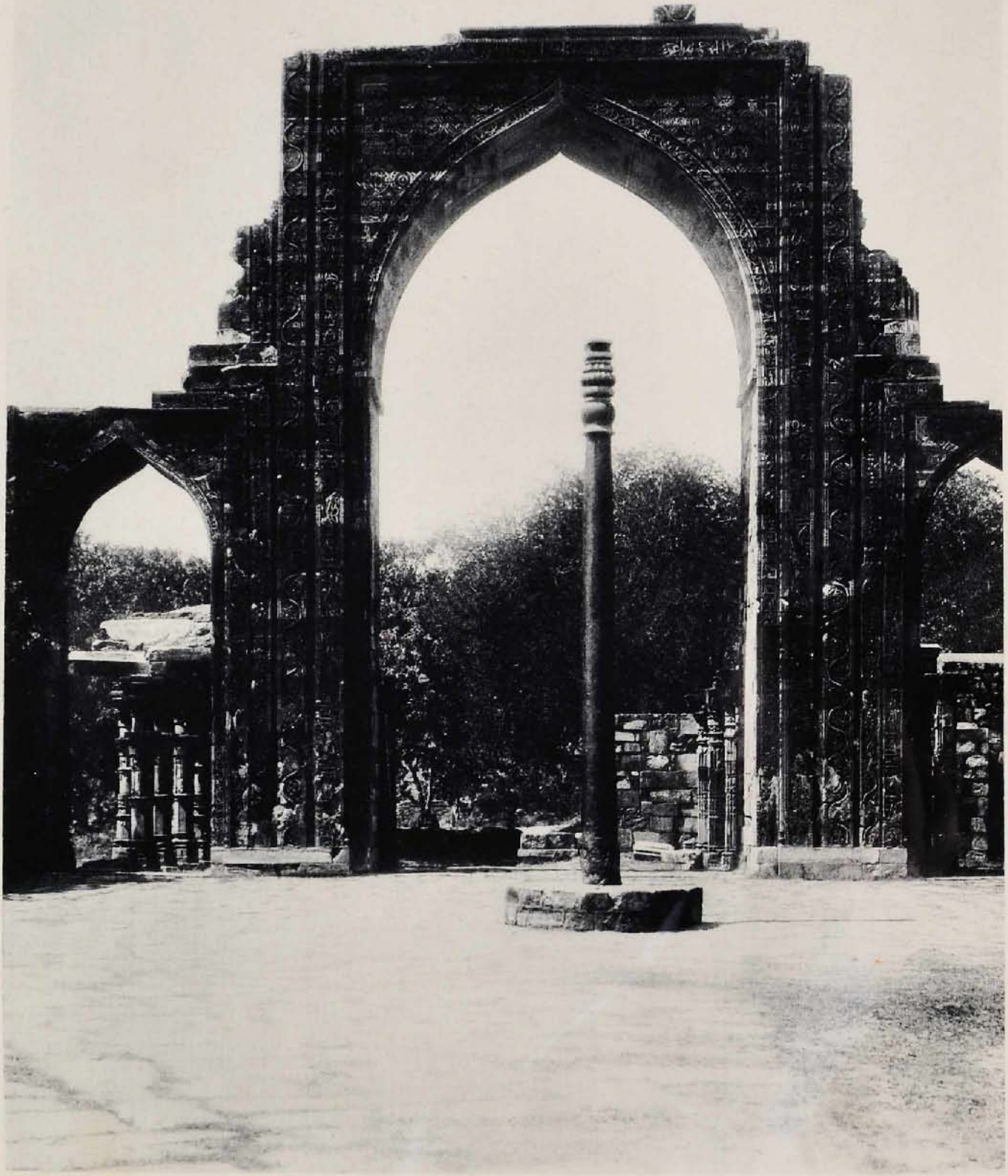
52. DELHI. — MOSQUÉE DU QOUTB ET LE PILIER DE FER
